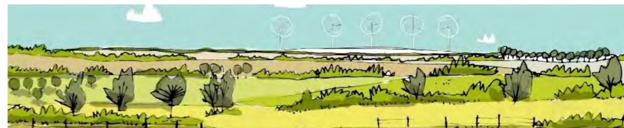
Topographie faisant ressortir l'élanement des éoliennes
