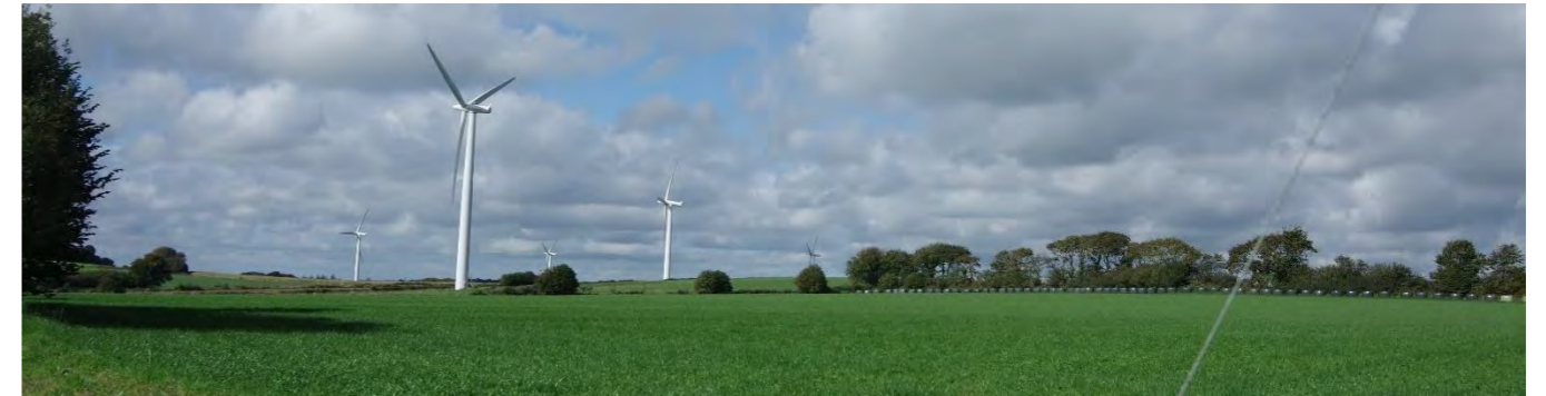
Les éoliennes du parc de Gollot perceptibles dans leur totalité depuis la D24, qui passe au pied des machines.
