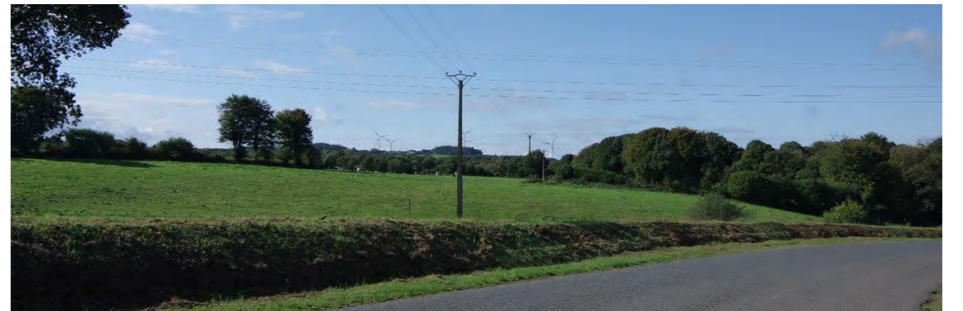
Le passage des lignes à haute tension, ponctuellement remarquable (D24) et pouvant être mises en covisibilité avec les parcs éoliens (ici celui de Bourbriac).
